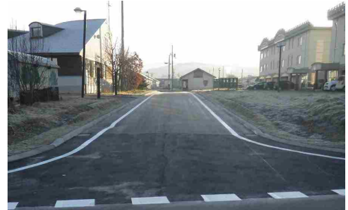
▲狹隘道路改良
